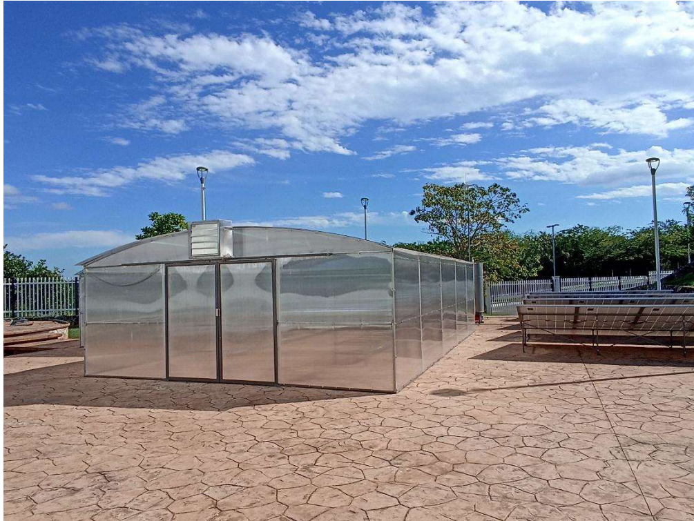
Figura 3. Secador tipo invernadero instalado la facultad de ingeniería UAC.
