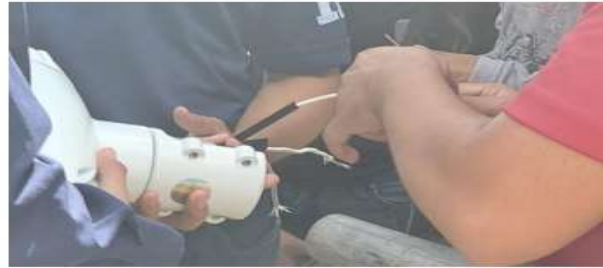
Ilustración 2. Conexiones entre los cables del aerogenerador y el mástil
