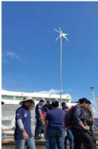
Ilustración 5. Erguimiento del aerogenerador colocado en el poste
