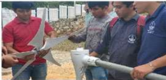
Ilustración 3. Instalación del alabe a la góndola del aerogenerador
